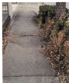
(舗装面損傷)
